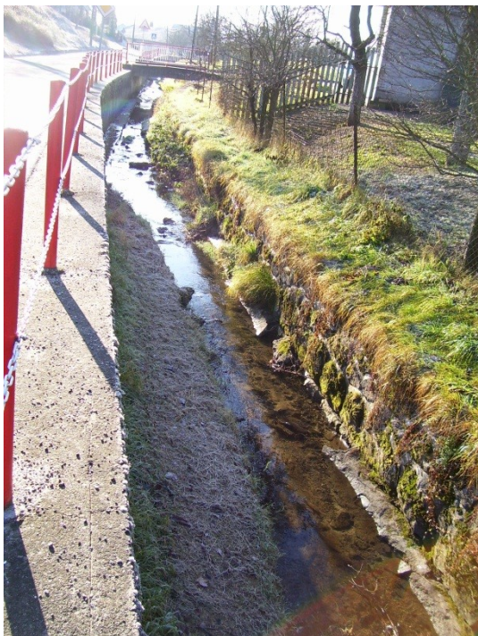
Obr. 9: Kamenné opevnění břehů v obci Lukoveček
