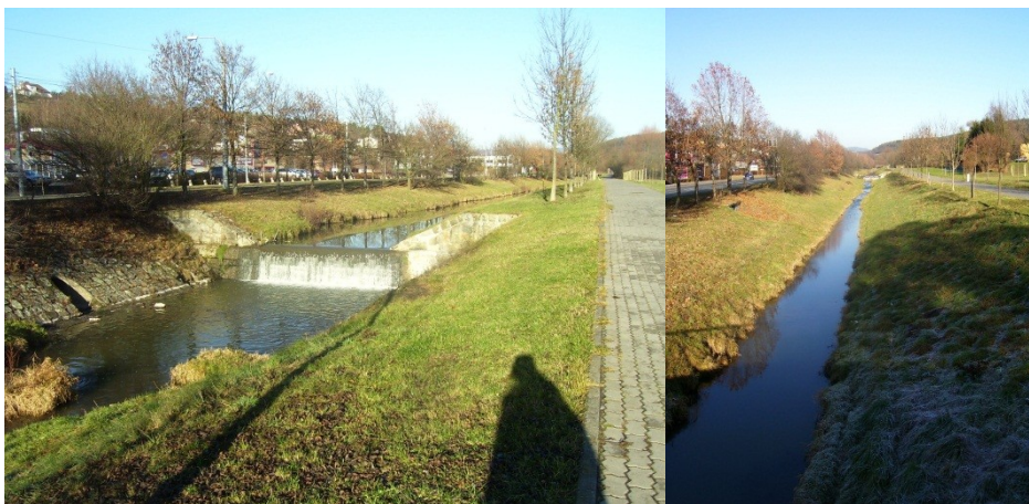
Obr. 12: Napřímení a zkapacitnění vodního toku s jezem, kamené opevnění a probírka břehů na Fryštáckém potoce ve Zlíně
