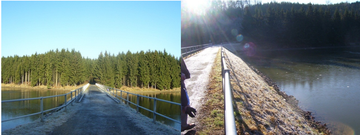
Obr. 11: Hráz na Fryštácké přehradě
