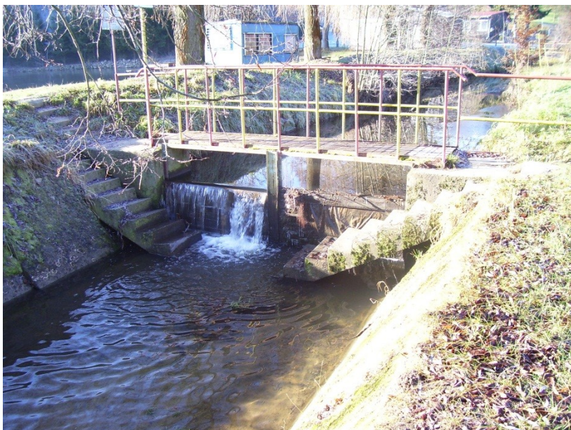
Obr. 10: Kamenné opevnění břehu a menším jezem v obci Fryšták
