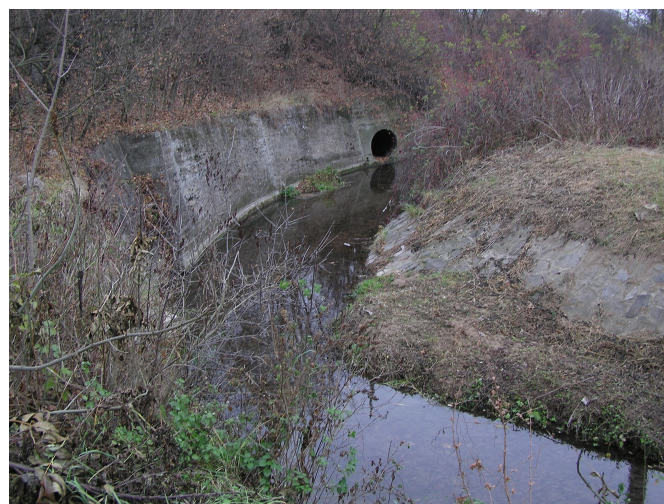
Obr.16 Betónom spevnené brehy
