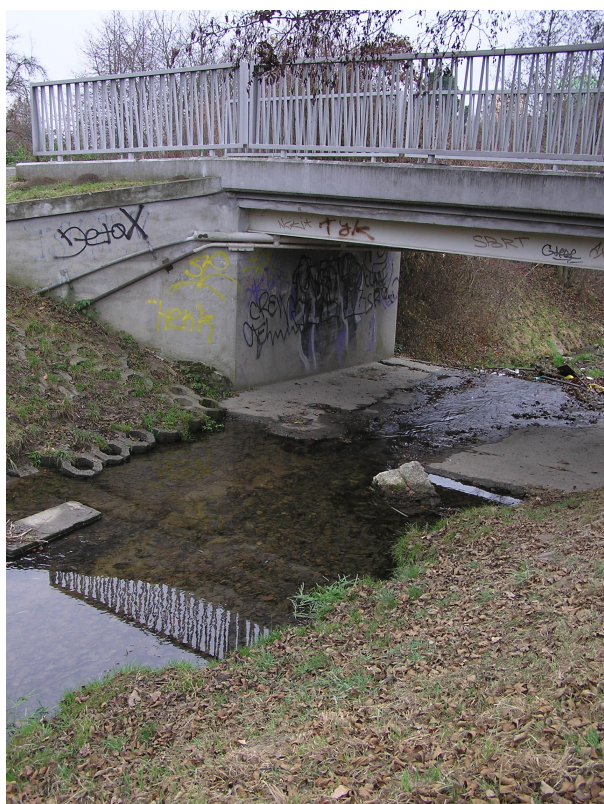
Obr.15 Spevnenie brehov polovegetačnými tvárnami, dno je spevnené betónovými doskami
