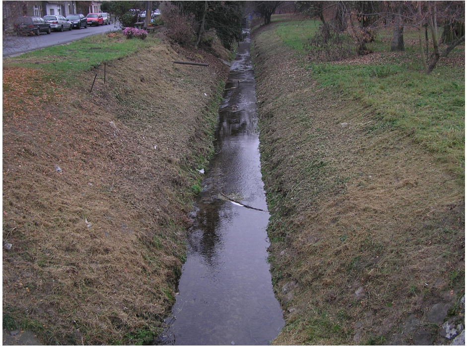
Obr.10 Napriamené a skapacitnené koryto, Královo Pole, ul. Myslínova
