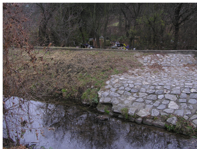
Obr.14 Kamenná stena na ľavom brehu
