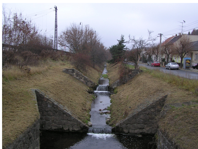
Obr.9 Napriamený tok v Královom Poli navyše s vybudovanými umelými stupňami
