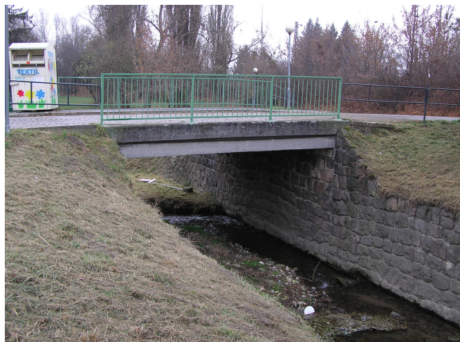
Obr.13 Spevnenie kamennou stenou, Královo Pole
