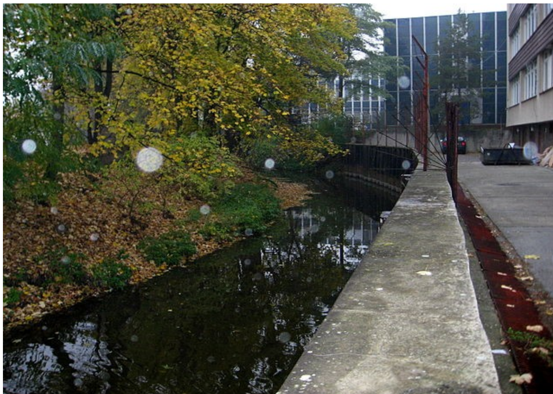
Obr.26 Čiastočne opevnený úsek poblíž Dornychu, v pozadí štetová stena
