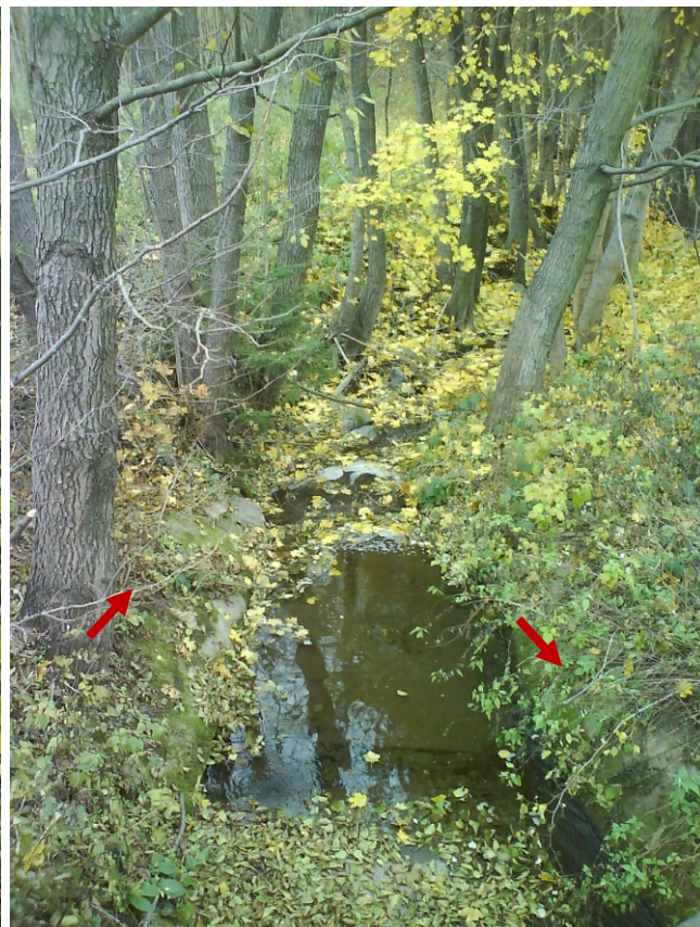
Obr. 7. Brehy a dno spevnené betónom pod mostíkom
