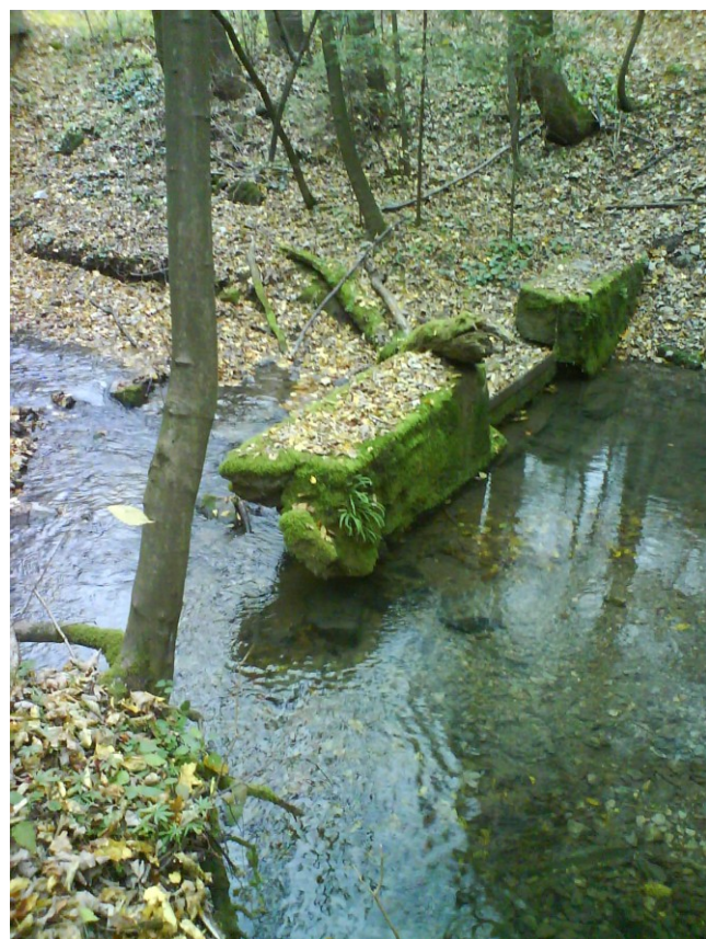
Obr. 9. Starý nefunkčný betónový stupeň v dolnej časti toku
