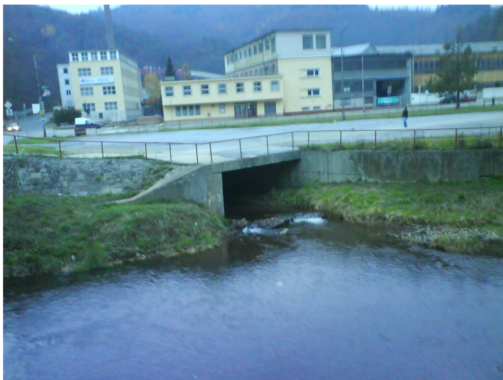
Obr. 5. Zakrytie koryta pred sútokom so Svitavou v Adamove
