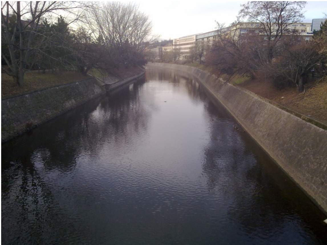
Obr. 13: Betonovo-kamenné břehy v Brně-Štýřici (foto autor, 18.12.2011)
