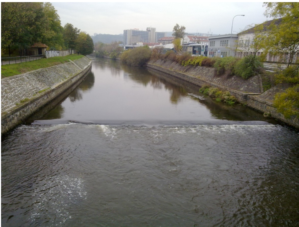
Obr. 21: Splav na páteřním toku na Starém Brně, beteno-kamenité břehy (foto autor, 6.11.2011)
