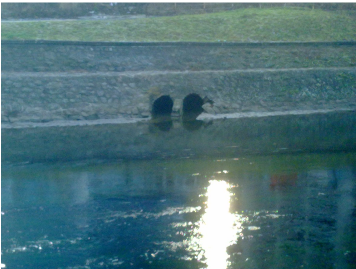
Obr. 23: Přívodní kanály kanalizace z okolí páteřního toku (Brno-Štýřice) (foto autor, 18.12.2011)
