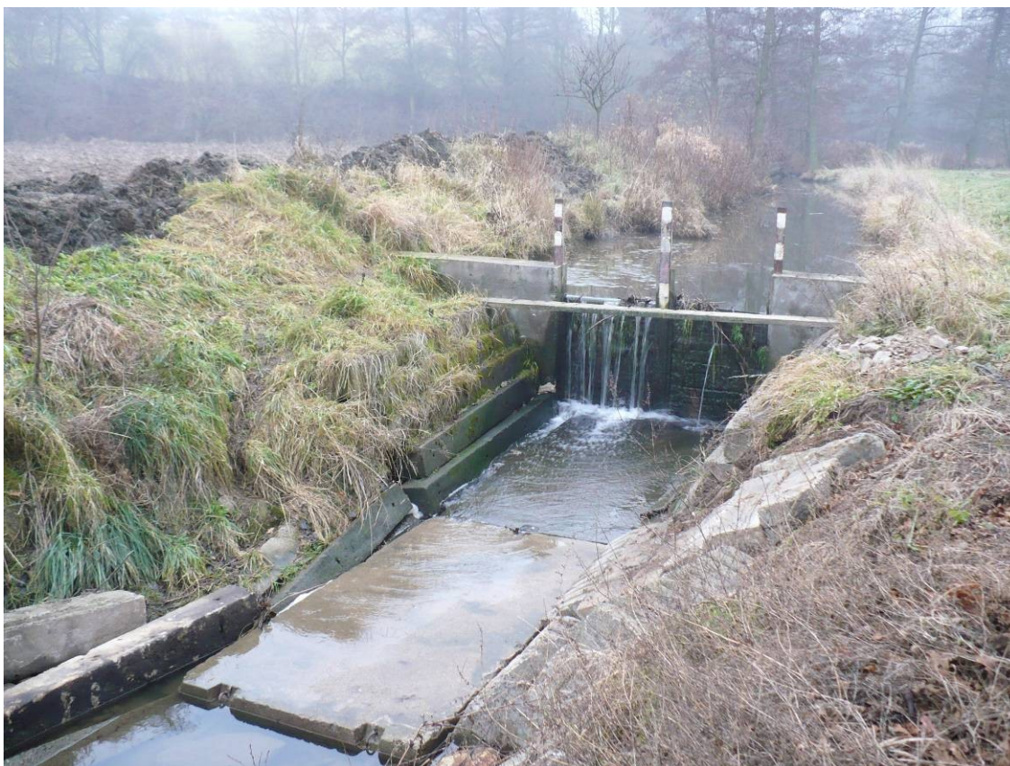
Foto 7 Umelý stupeň s výškou vyšší než 1 m s následným vzdutím hladiny proti proudu (T. Bumba 2011)
