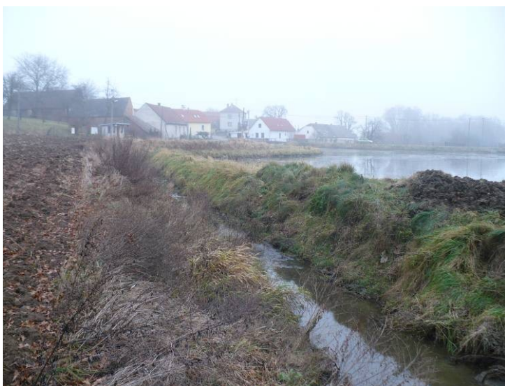
Foto 5 Napřimený a zkapacitněný úsek toku v Hvězdoňovicích. Koryto je vedeno netypicky podél hráze rybníka Vyběral, do kterého neústí. (T. Bumba 2011)
