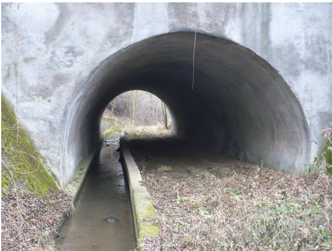
Foto 10 Betonem vytvořené koryto toku pod Železničním násypem u Hvězdoňovic o délce několika desítek metrů (T. Bumba 2011)
