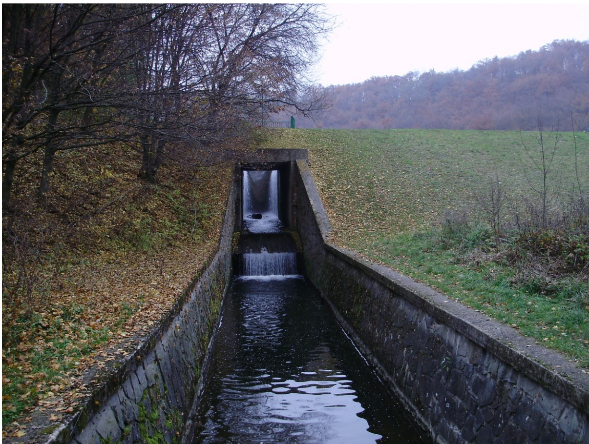
Foto 10 Přepad nádrže Pod Hrádkem
