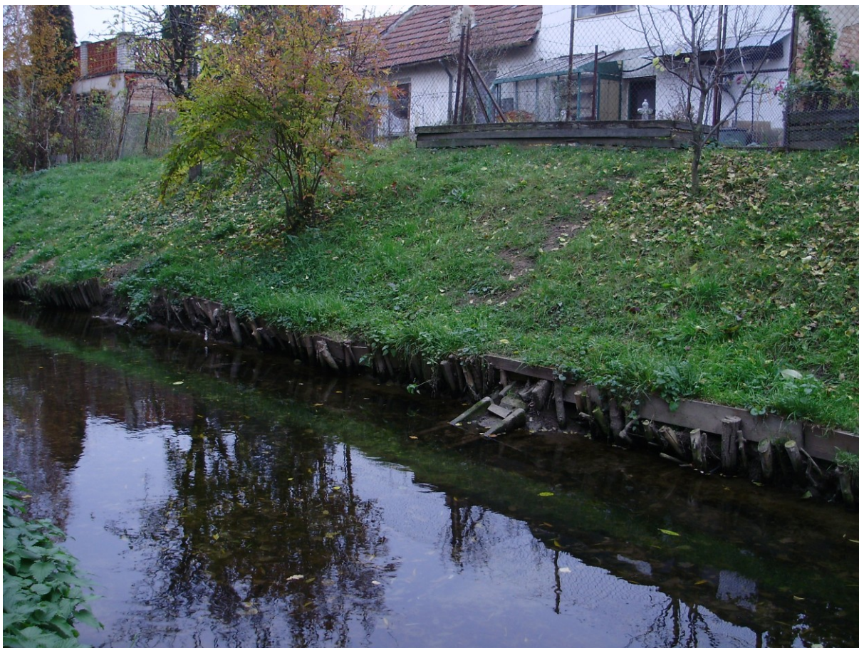
Foto 15 Zpevněný břeh Řičky ve Šlapanicích (pouze dřevem)
