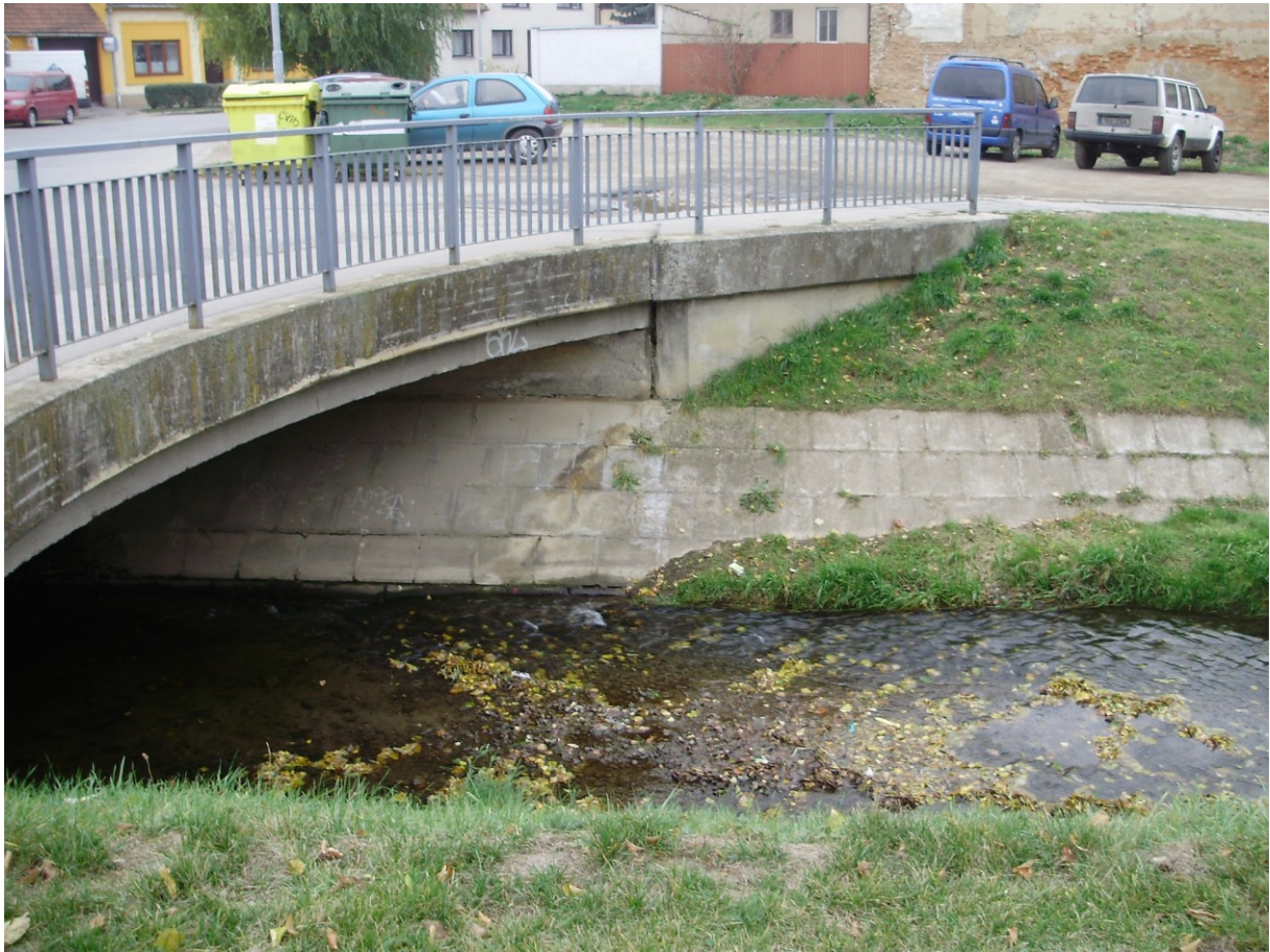
Foto 14 Zpevněný břeh Řičky ve Šlapanicích
