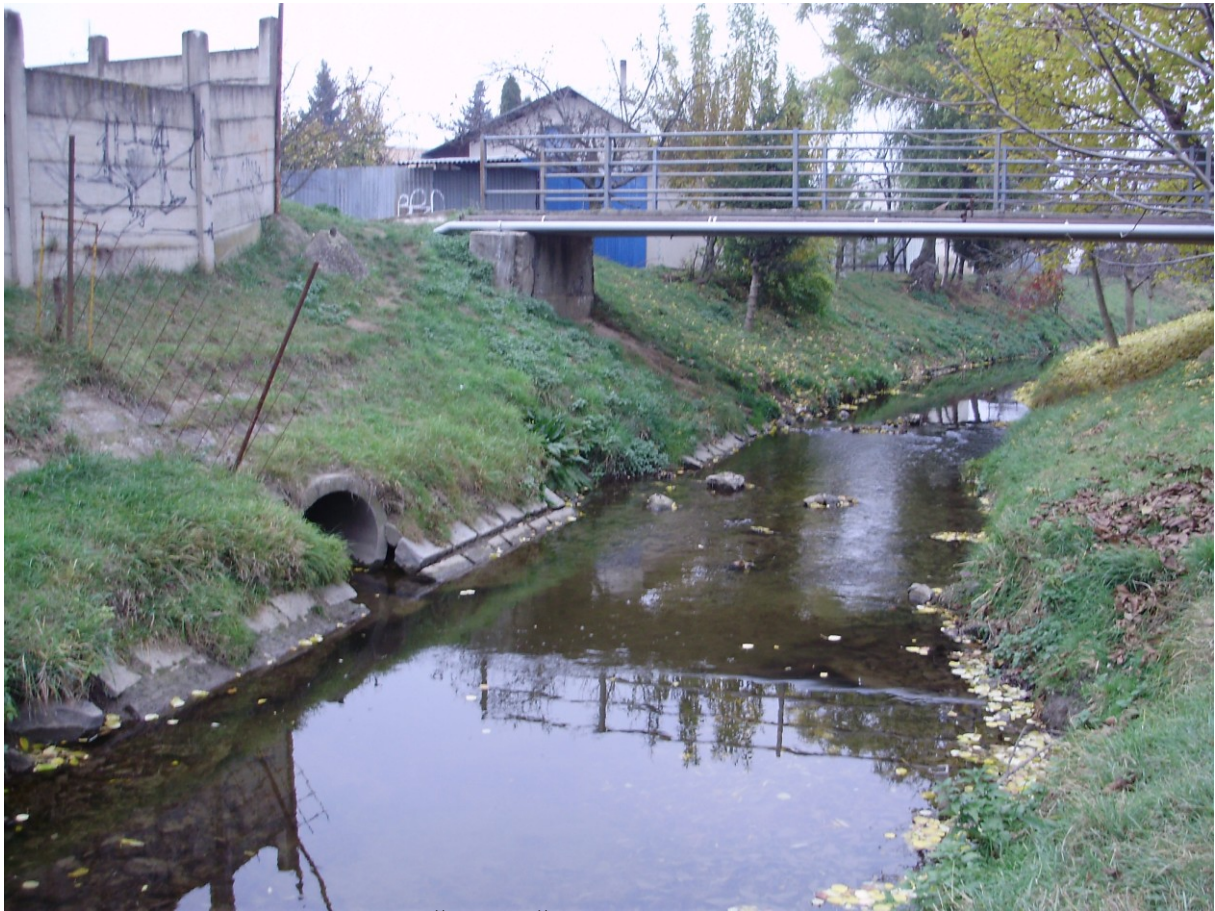
Foto 17 Zpevnění břehu a napřímení Řičky ve Šlapanicích
