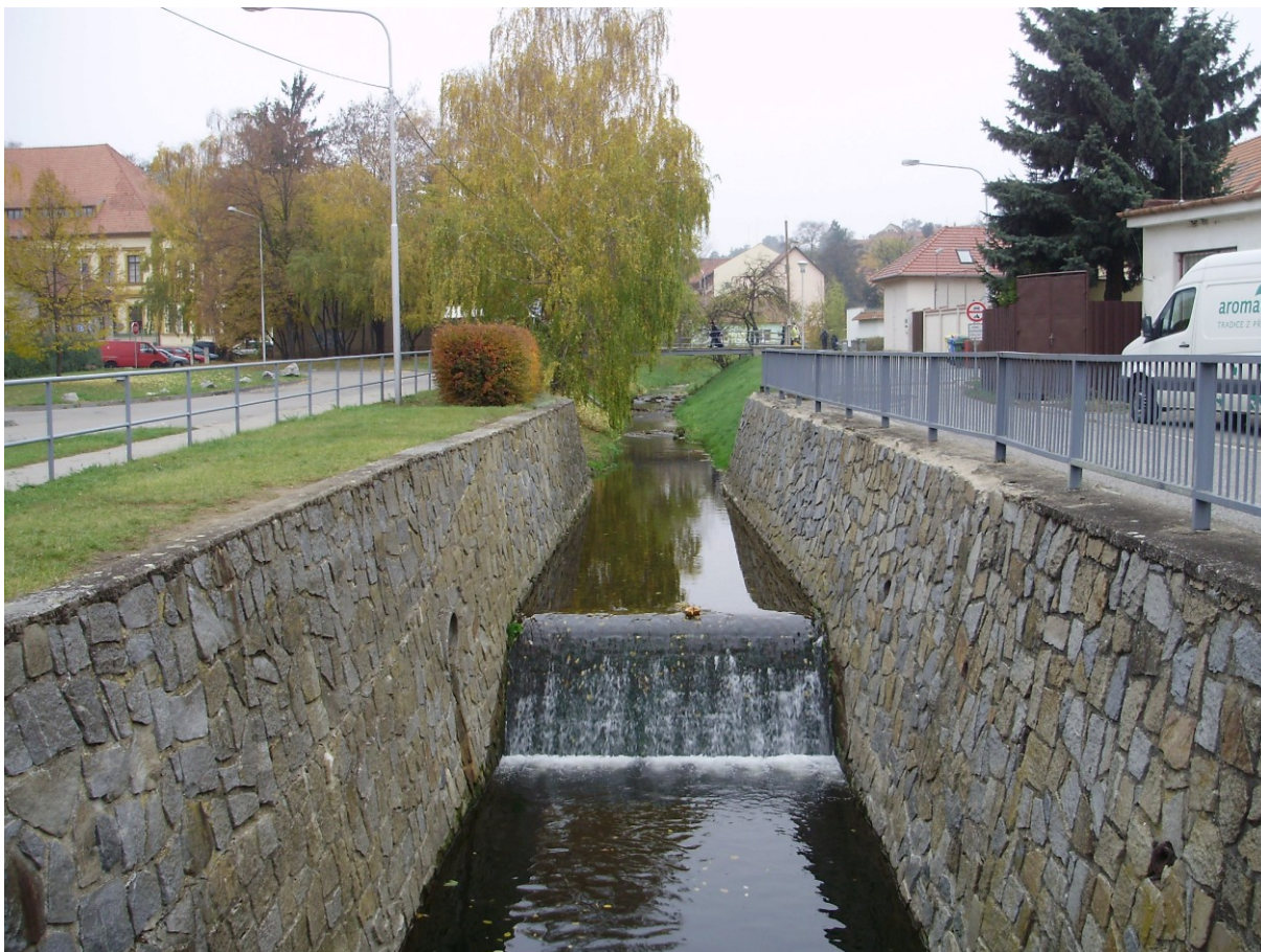
Foto 13 Zpevněné břehy a stupeň v korytě Říčky ve Šlapanicích (hlavní křižovatka)
