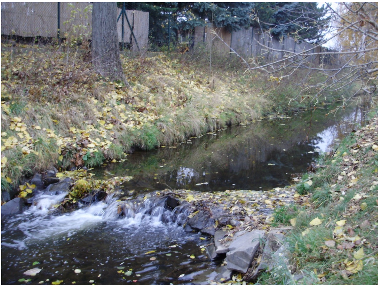
Foto 18 Stupeň v korytě Říčky pod Šlapanicemi
