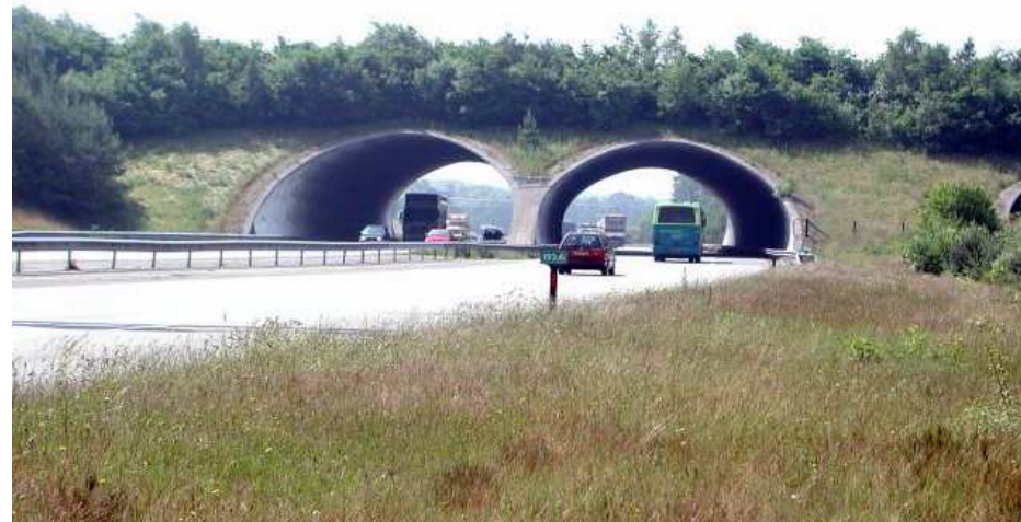
Nadchod pro zvěř na dálnici v Nizozemsku
