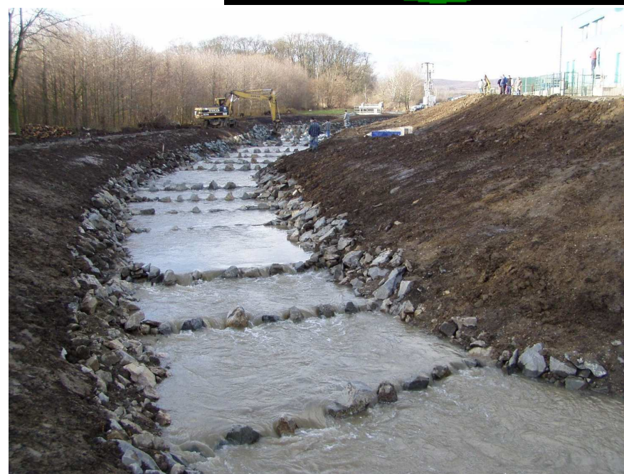
Rybí přechod na Dyji u Bulhar
