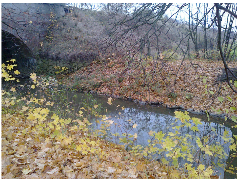
Obr. 3: Železniční most nacházející se nad sledovanou částí řeky
