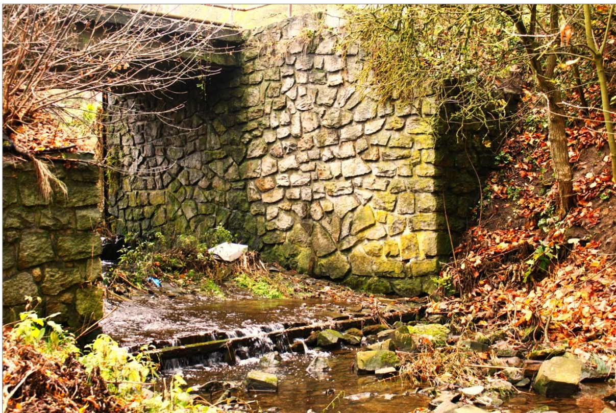
Obr. č. II: Ukázka lidské činnosti na vodním toku Kuřimka v podobě kamenného mostu a přehradní lačky
