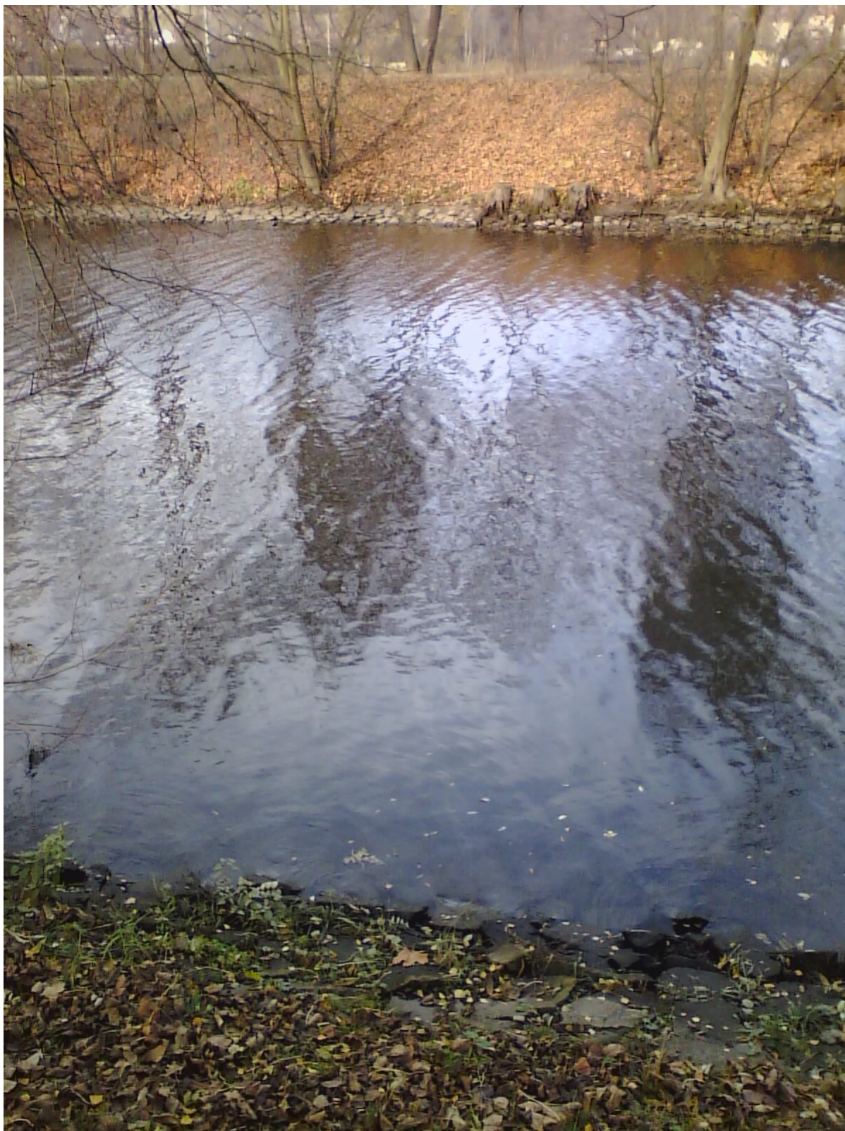
Obr. 1: Pohled na břehy zpevněné kameny.
