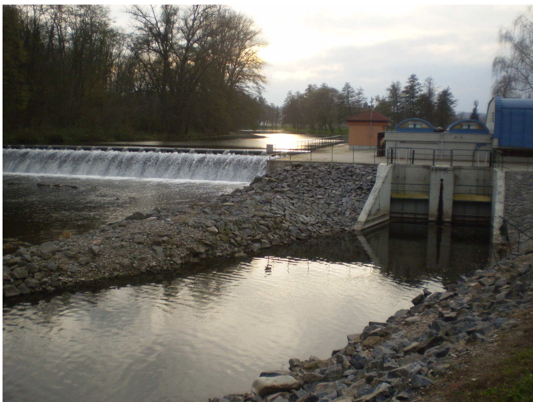
Obr.4: Umělé migrační bariéry: jez a vodní elektrárna MVE Ivančice (vlastní fototafie 2012)
