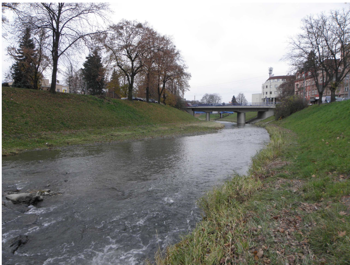
FOTO 1 : Mělké koryto Dřevnice s akumulací v levé části toku.
