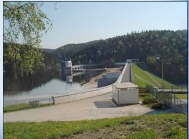
Obr. 5: Hráz vodní nádrže Hracholusky
