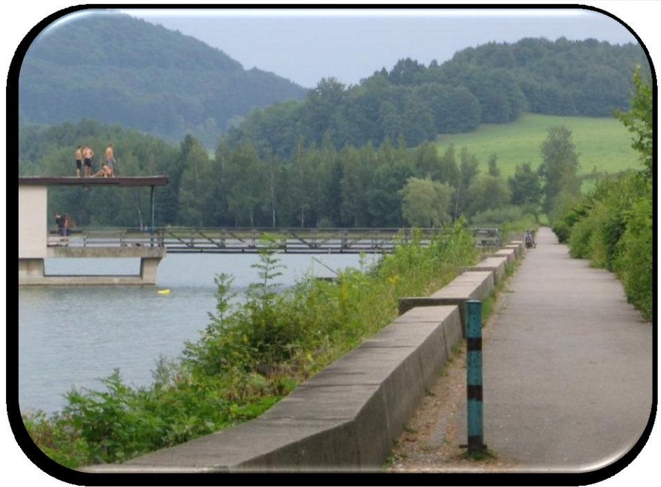
Obr. 4: Hráz údolní nádrže Větrkovice
