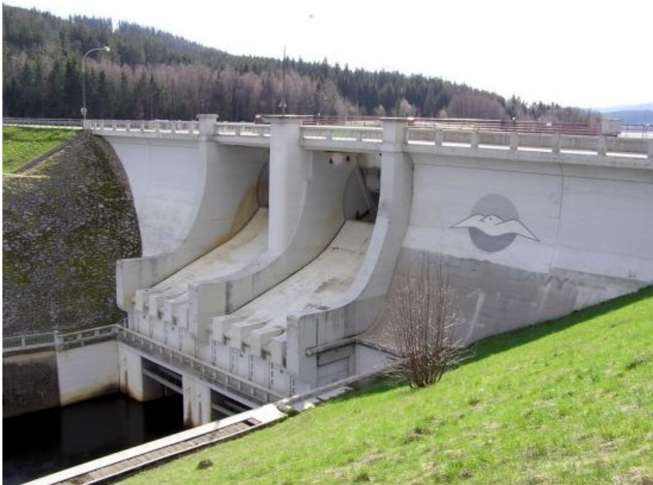
Betonový funkční blok hráze (J. Švejda) Fotogalerie přehrady
