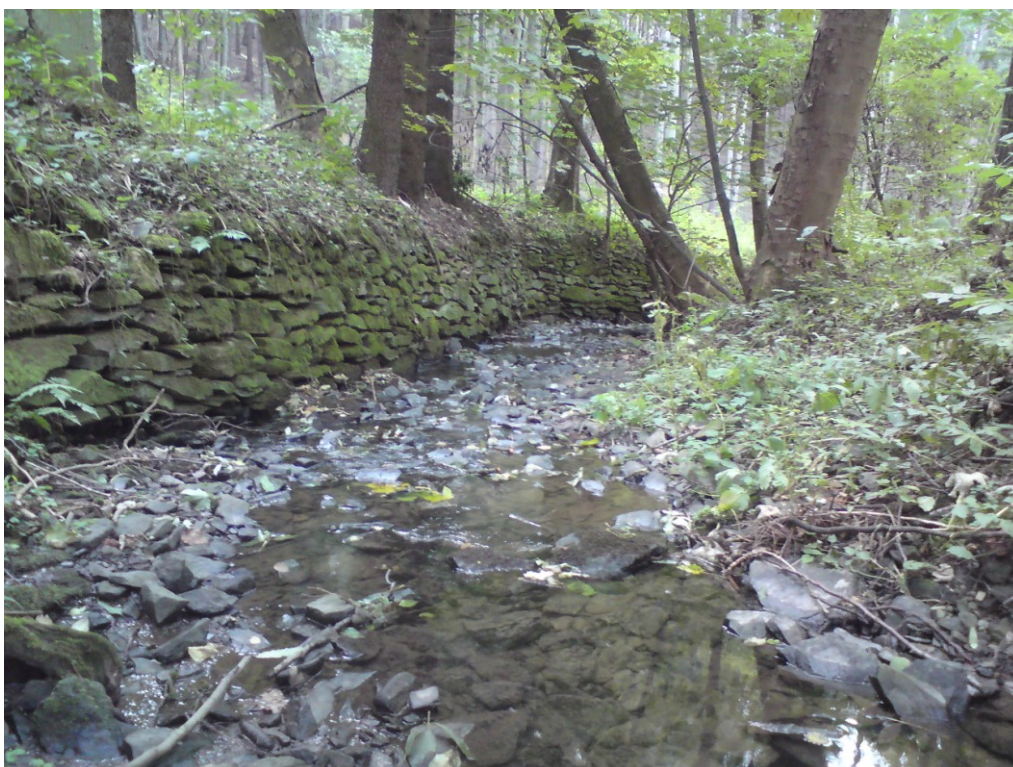
Obr. 6 Kořenecký potok – zpevnění břehu
