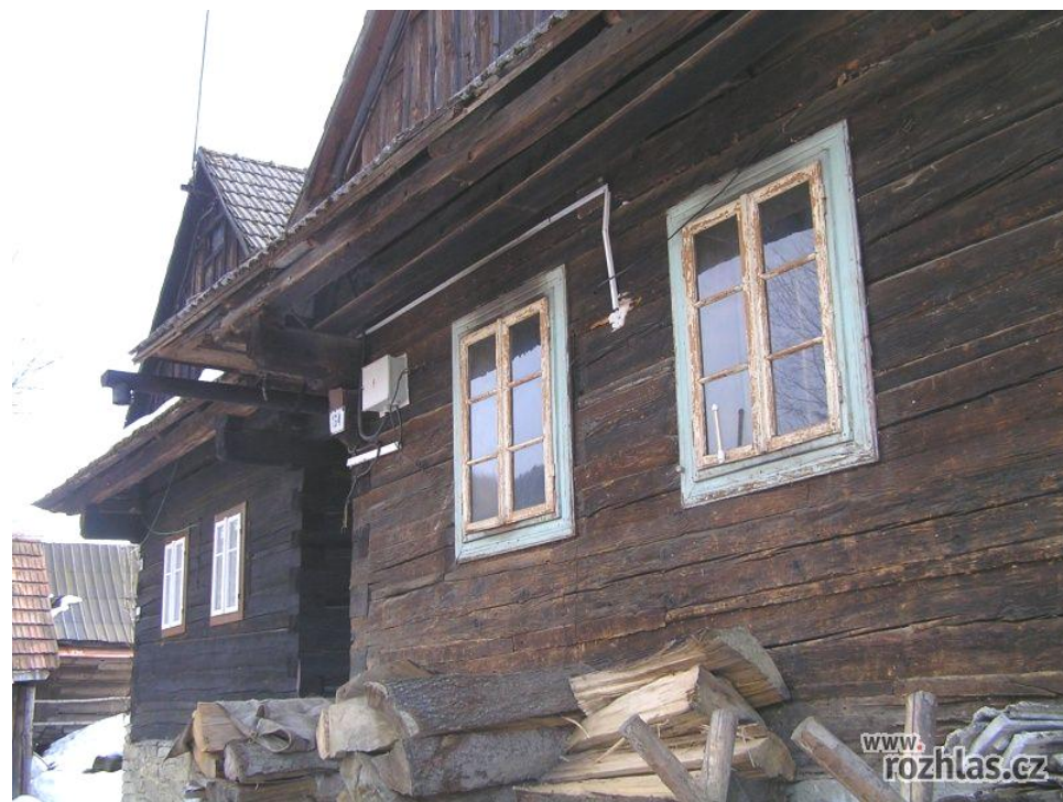
starší valašský dům – přízemní, roubený - velký přesah střechy - šindel, kabřinec
