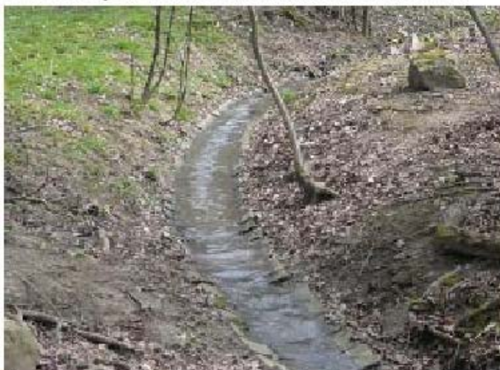
Zpevnění dna betonem – prefabrikované profily
