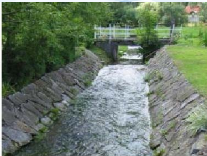
Souvislá úprava dna i břehů kamennou dlažbou
