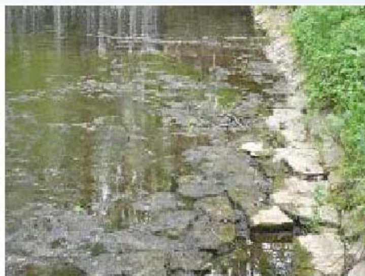
Zpevnění dna kamennou dlažbou.
