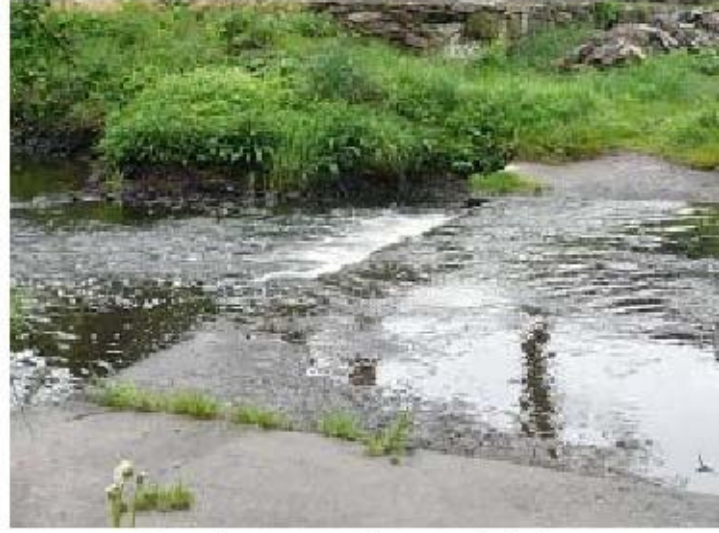
Zpevnění dna betonem – betonové desky
