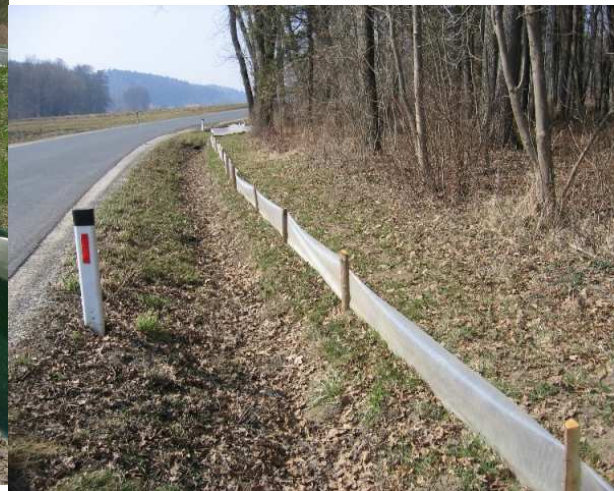
Záchytné ploty s padacími pastmi k zachycení táhnoucích obojživelníků a jejich následné přenesení přes silnici, resp. na trdliště (Rakousko) – dočasné opatření (pozor na jednosměrnost zařízení!)
