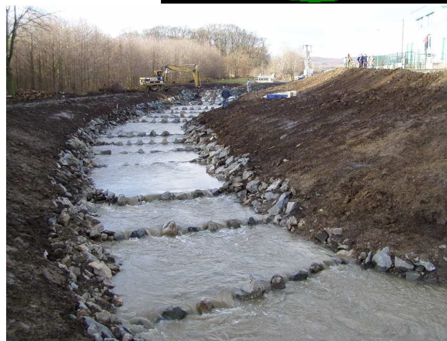
Rybí přechod na Dyji u Bulhar
