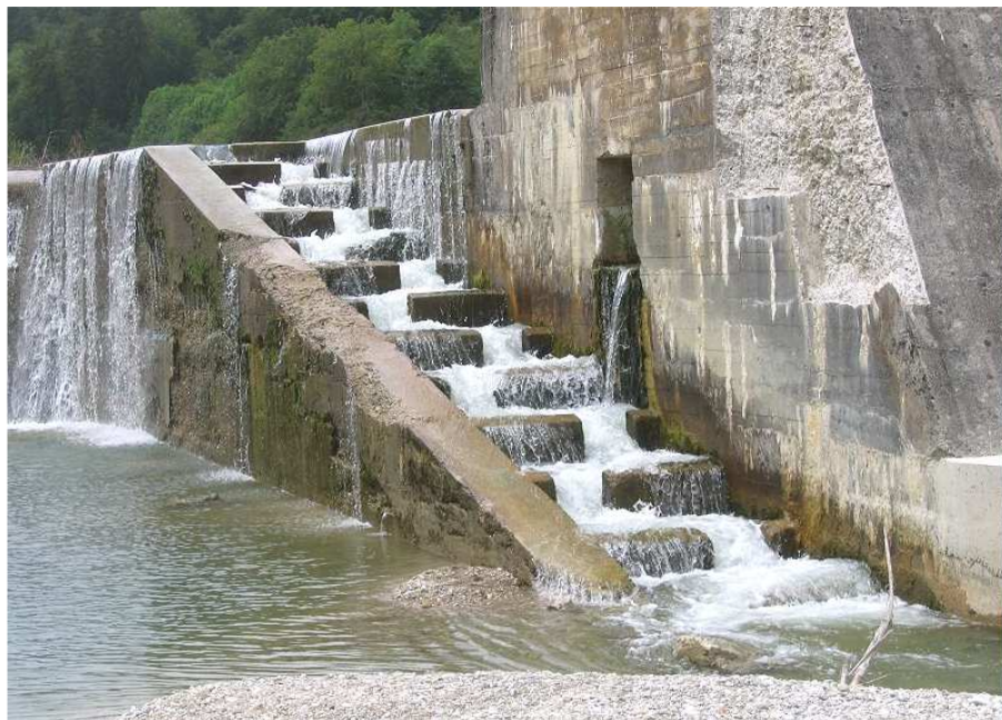
Rybí přechod na řece Isar, Německo
