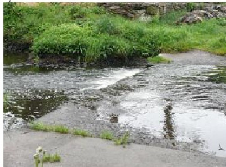
Zpevnění dna betonem – betonové desky
