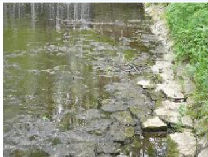
Zpevnění dna kamennou dlažbou.
