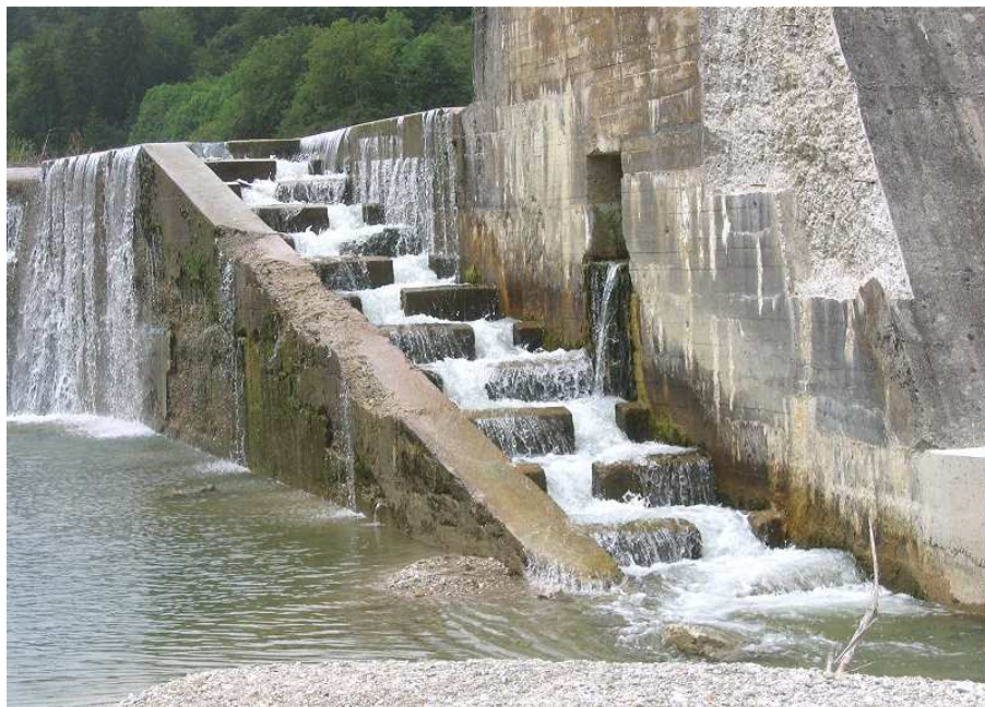
Rybí přechod na řece Isar, Německo
