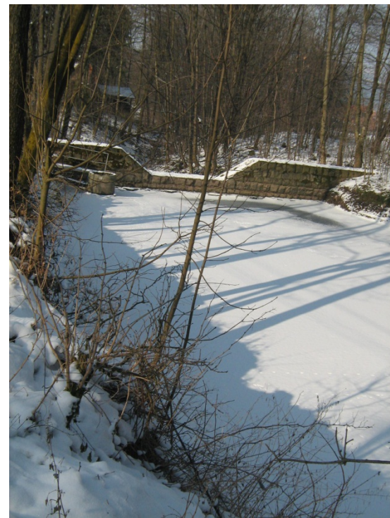
AKUMULAČNÍ PROSTOR NAD PŘEHRÁŽKOU
