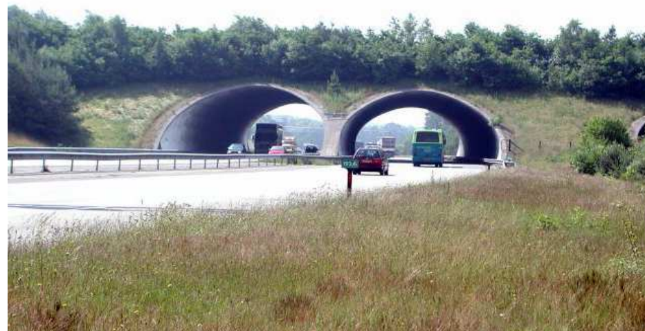
Nadchod pro zvěř na dálnici v Nizozemsku
