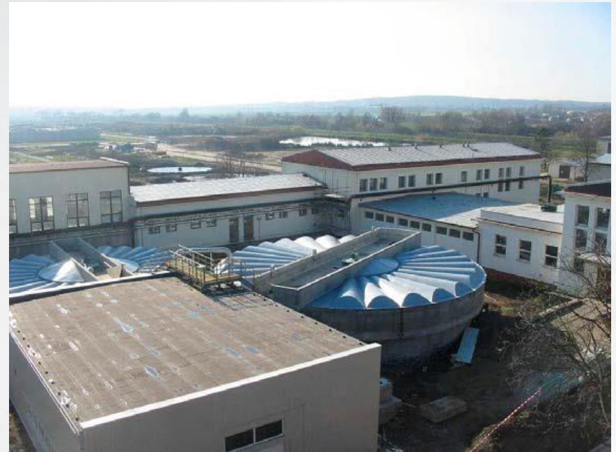
Zahušťovací nádrž, Flotační jednotka ČOV Brno - Modřice
