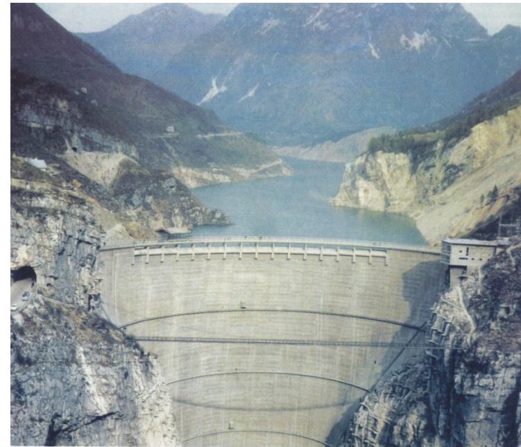
Tal des Lago di Vaiont im Oktober 1963. In den Stausee stürzten die Felsmassen des Monte Toc.
