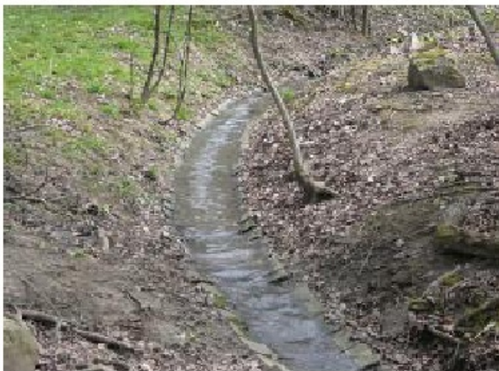
Zpevnění dna betonem – prefabrikované profily
