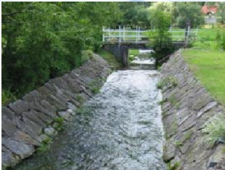
Souvislá úprava dna i břehů kamennou dlažbou
