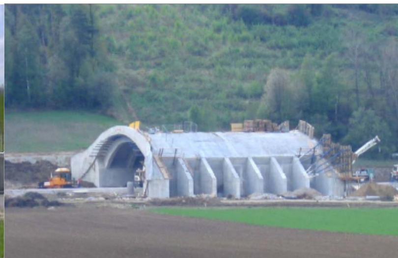
Stavba nadchodu pro velké savce na trati v Dol. Rakousku
