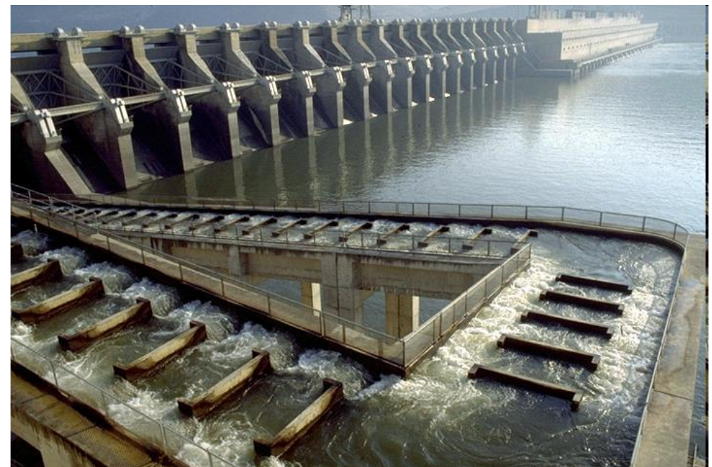
Rybí přechod na řece Columbia, USA (přehrada John Day Dam)
