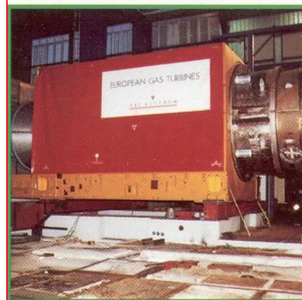
Montáž plynové turbíny č. 1 na základy
