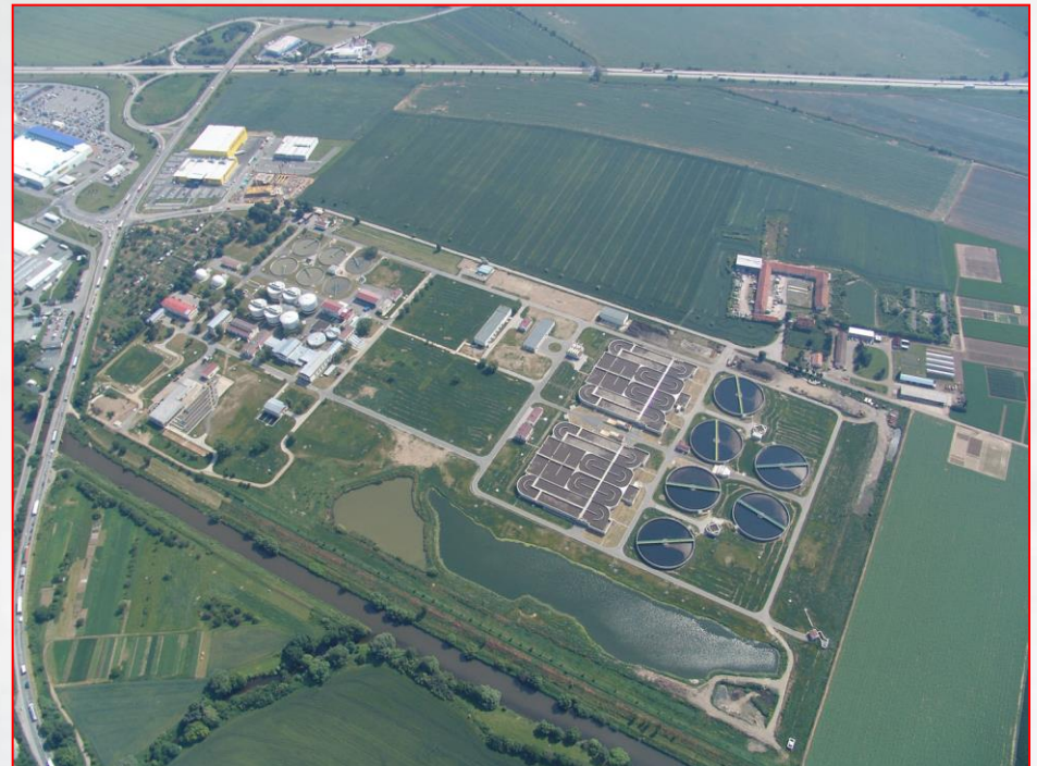
Čistírna odpadních vod v Brně - Modřičích
