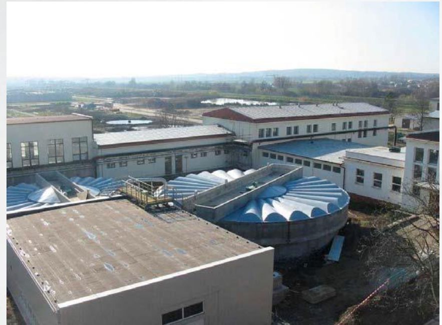
Zahušťovací nádrž, Flotační jednotka ČOV Brno - Modřice
