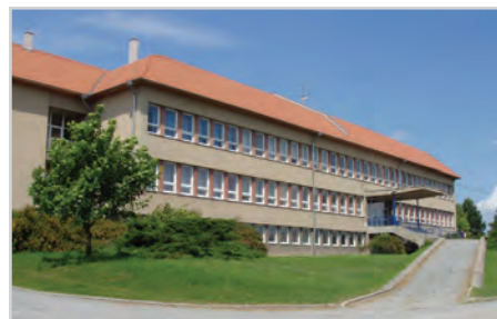
Budova nové školy
