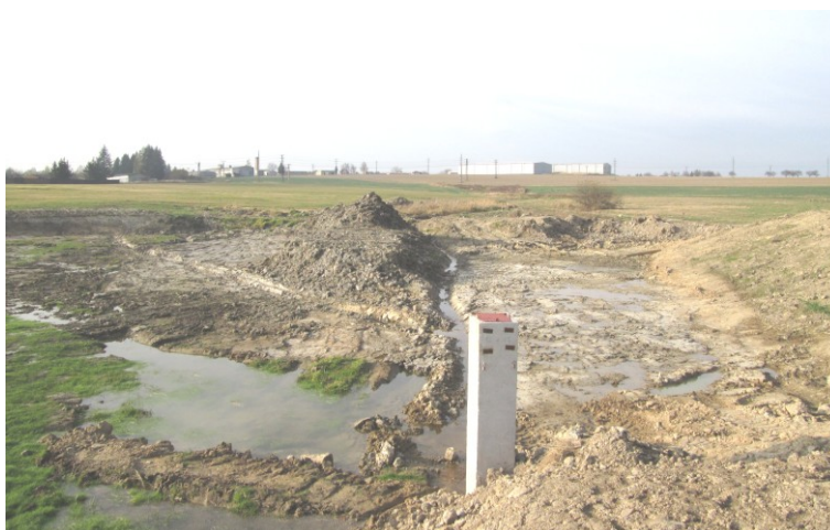
Obr. 13 Nejvýše položená nádrž ze soustavy vodních nádrží Bělidla, na níž probíhají terénní úpravy
