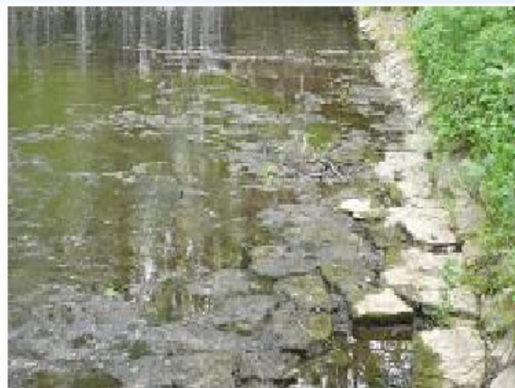
Zpevnění dna kamennou dlažbou.
