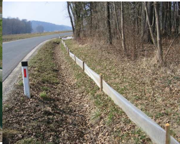
Záchytné ploty s padacími pastmi k zachycení táhnoucích obojživelníků a jejich následné přenesení přes silnici, resp. na trdliště (Rakousko) – dočasné opatření (pozor na jednosměrnost zařízení!)
