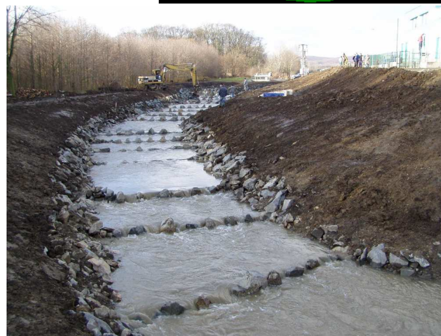
Rybí přechod na Dyji u Bulhar
