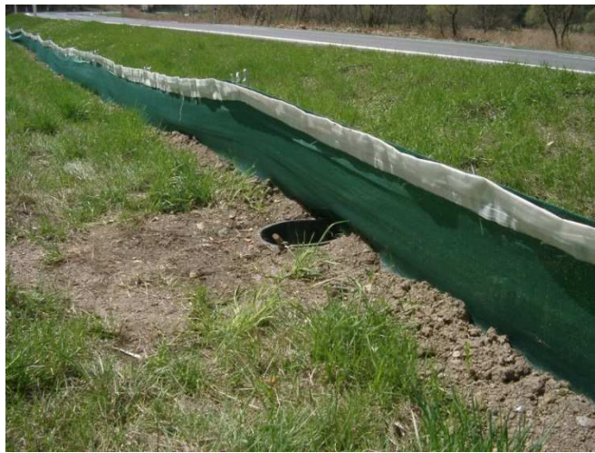
Záchytné ploty s padacími pastmi k zachycení táhnoucích obojživelníků a jejich následné přenesení přes silnici, resp. na trdliště (Rakousko) – dočasné opatření (pozor na jednosměrnost zařízení!)
