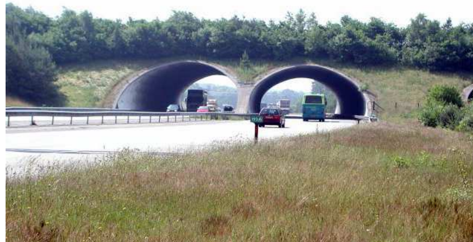
Nadchod pro zvěř na dálnici v Nizozemsku
