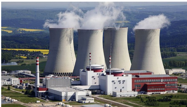
Chladící věže jaderné elektrárny Temelín
