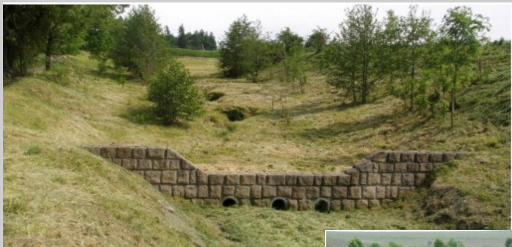
Protipovodňová přehrážka v k.ú. Lichnov
