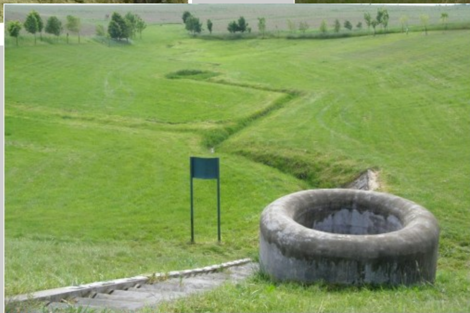
Suchá retenční nádrž v k.ú. Pustá Polom
