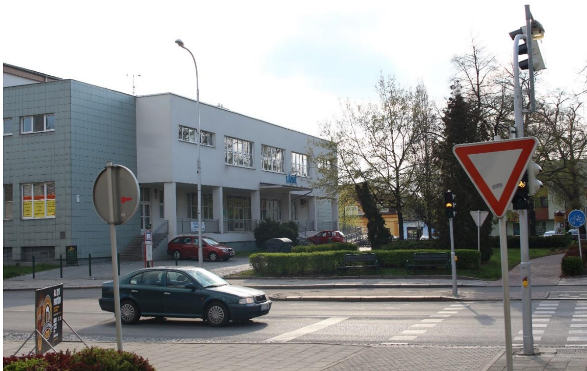
Obr. 3 Pohled na budovu Městských lázní a okolí od centra Prostějova (foto autor, 14. 4. 2017)
