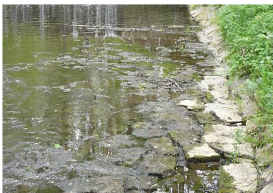
Zpevnění dna kamennou dlažbou.
