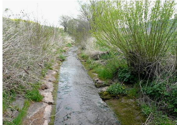
Zpevnění břehu betonem
