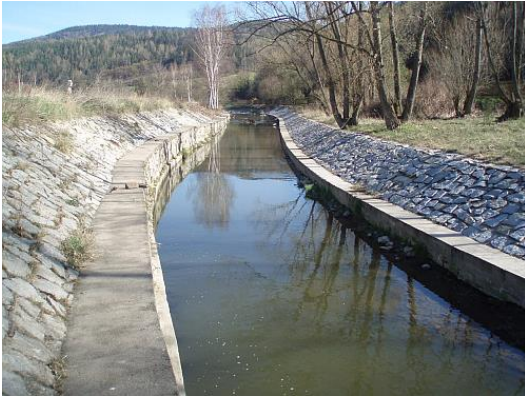
Souvislá úprava profilu - zpevnění břehu i dna betonovými deskami (vlevo), kam.dlažbou (vpravo)
