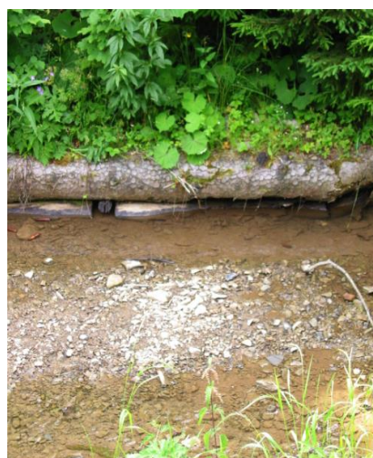
Vegetační opevnění břehu kulatinou
