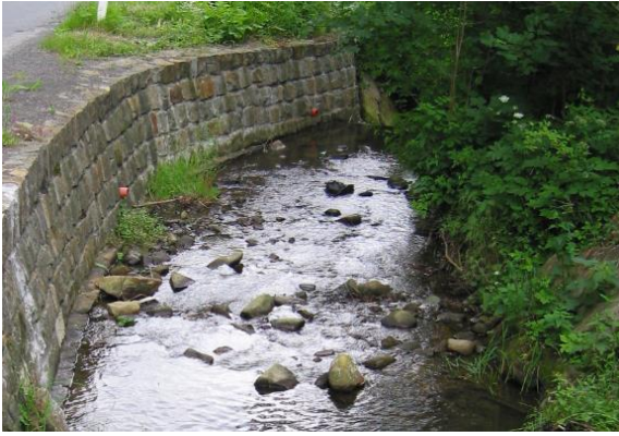
Zpevnění břehu kamennou dlažbou
