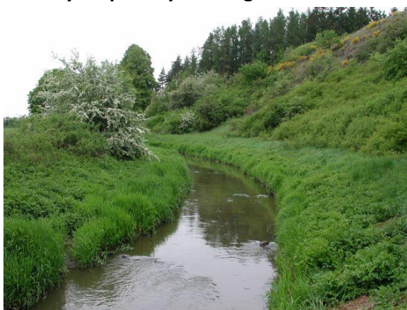
Vegetační opevnění – zatravnění hrany břehu
