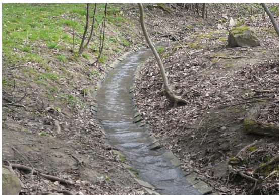
Zpevnění dna betonem – prefabrikované profily
