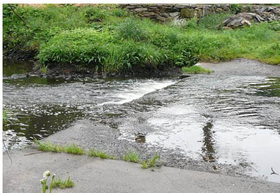
Zpevnění dna betonem – betonové desky
