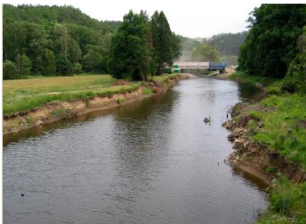
Rozsáhlá břehová nátrž
