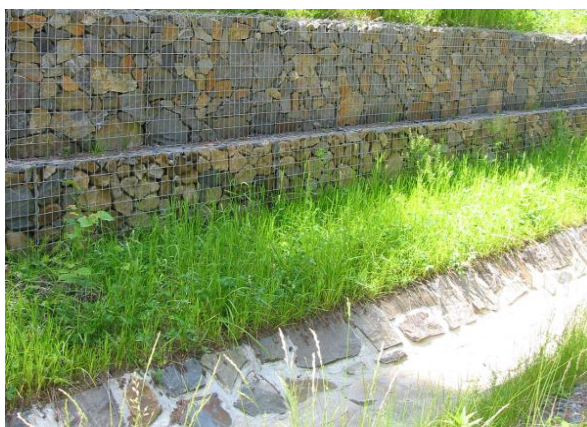
Gabiony na břehu koryta, koryto zpevněno kam.dlažbou
