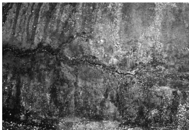
Obr.8. Korozní praskání korozivzdorné oceli.
