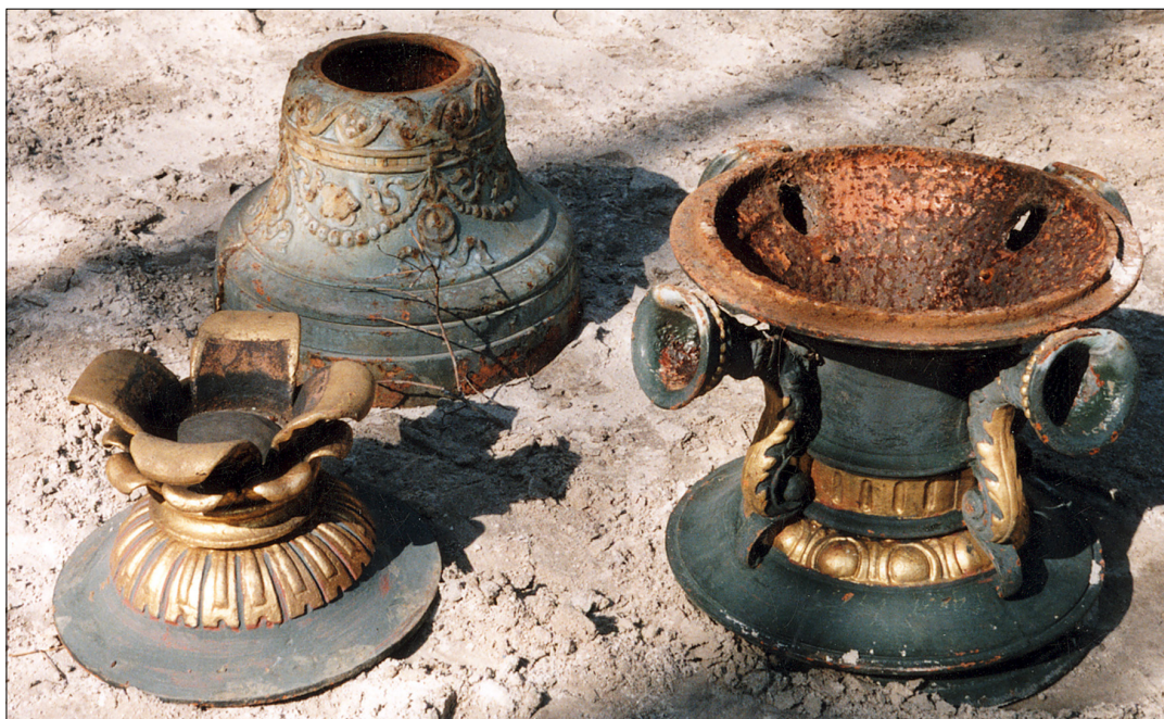
Obr. 17: Litinové detaily kašny, původní stav před konzervováním-restaurováním
