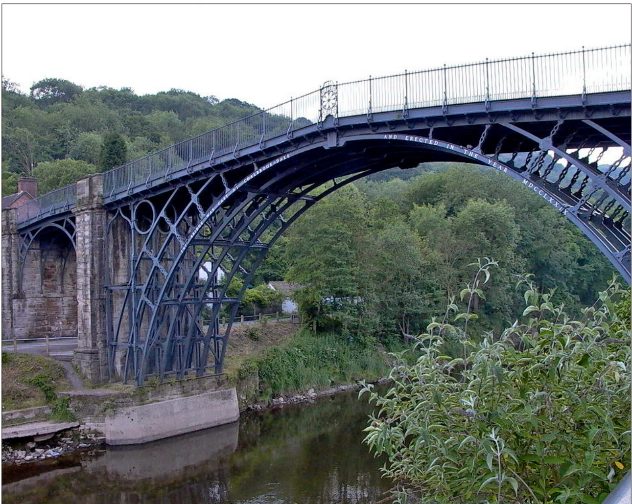
Obr. 2: Litinový most Iron Bridge přes řeku Severn blízko Coalbrookdale, Anglie (1779). http://www.wikiwand.com/cs/Iron_Bridge
