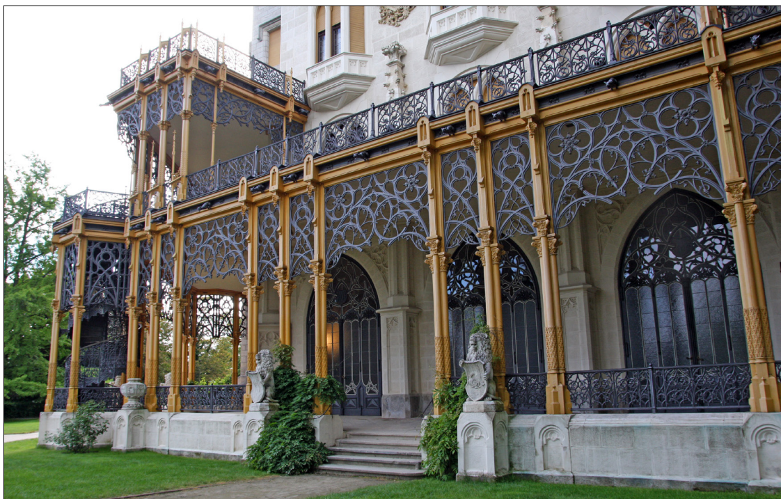
Obr. 11: Státní zámek Hluboká nad Vltavou, dekorativní litina na kolonádě a zábradlí, vlevo točité samonosné litinové schodiště, montovaná konstrukce
