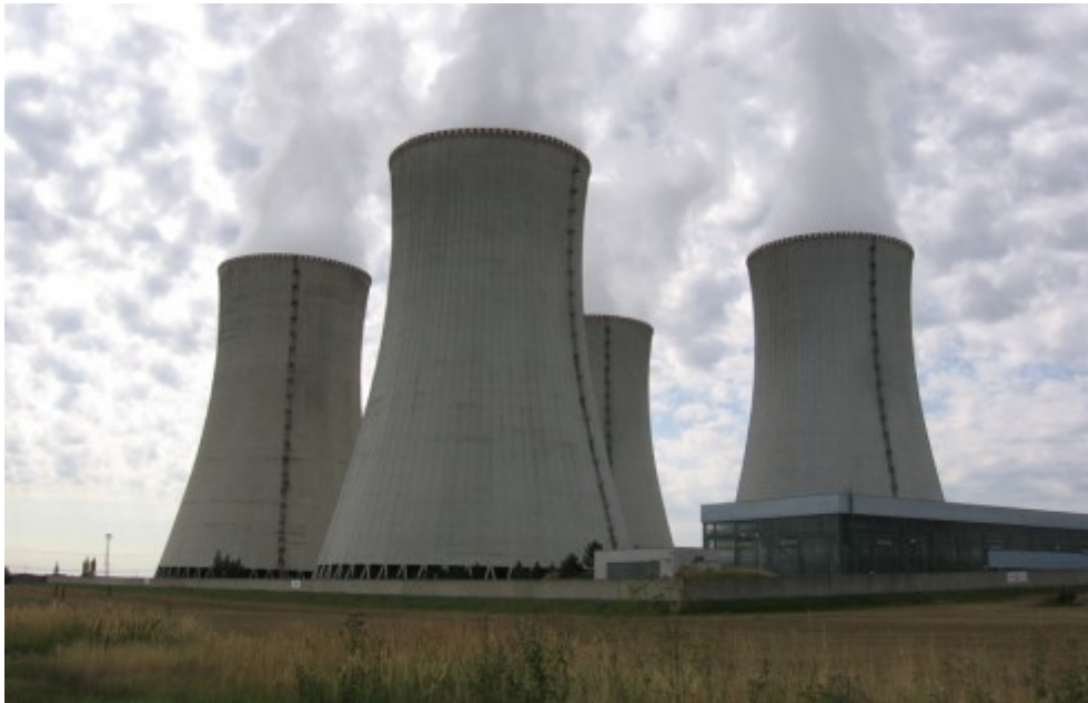
Reaktor typu VVER používá i elektrárna v Dukovanech. Foto CC BY-SA: Dr. Killer
