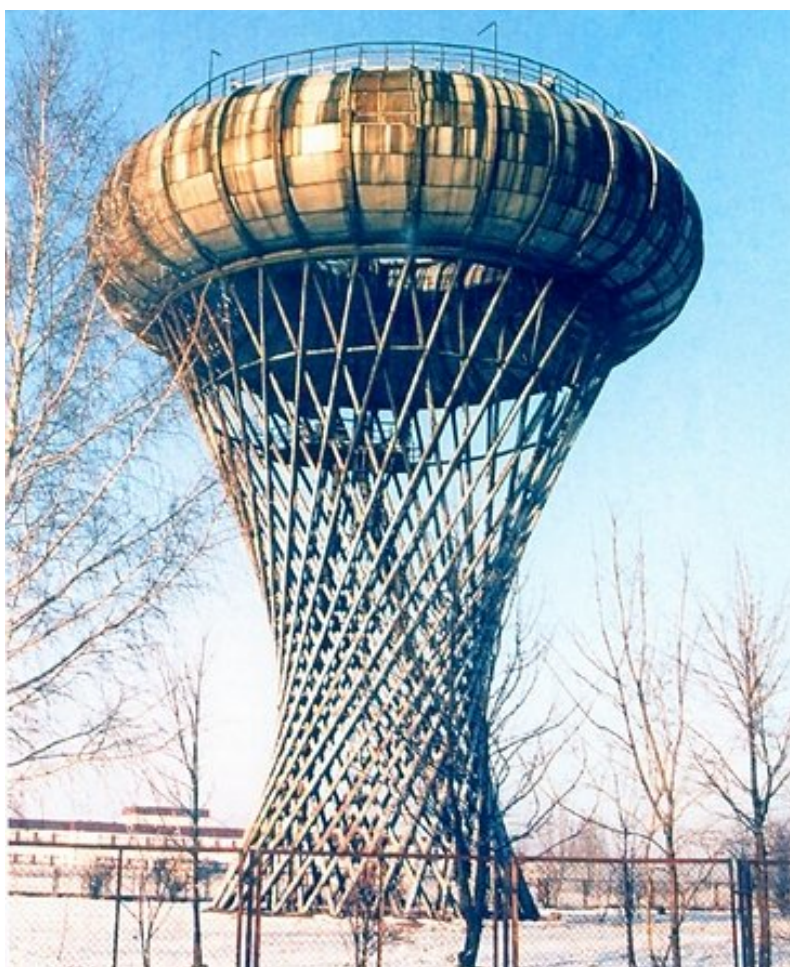
Vodojem na okraji Ciechanowa, Polsko
