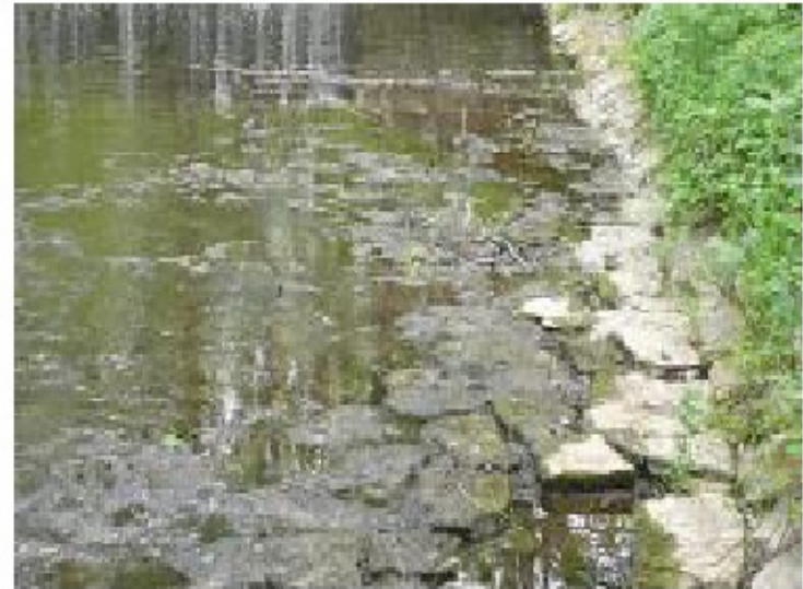
Zpevnění dna kamennou dlažbou.
