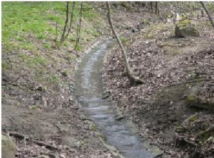
Zpevnění dna betonem – prefabrikované profily
