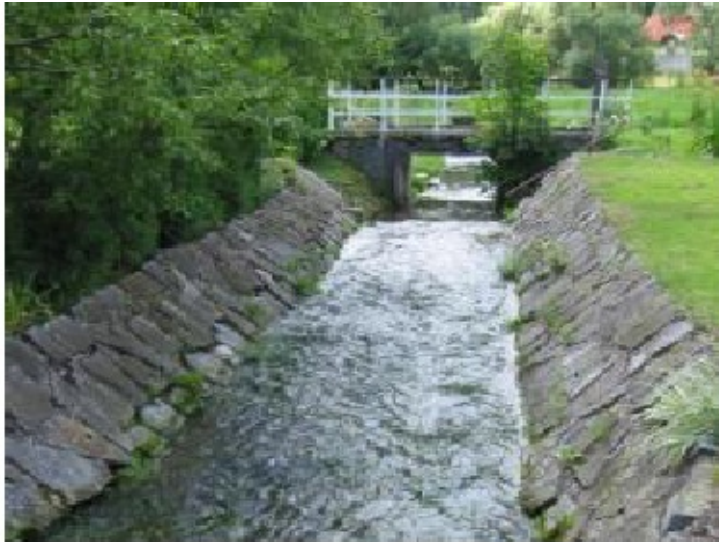
Souvislá úprava dna i břehů kamennou dlažbou
