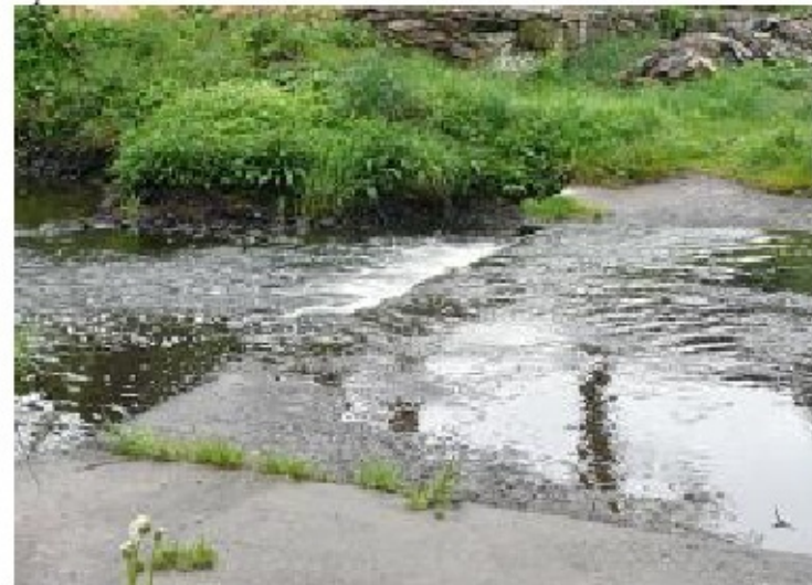
Zpevnění dna betonem – betonové desky
