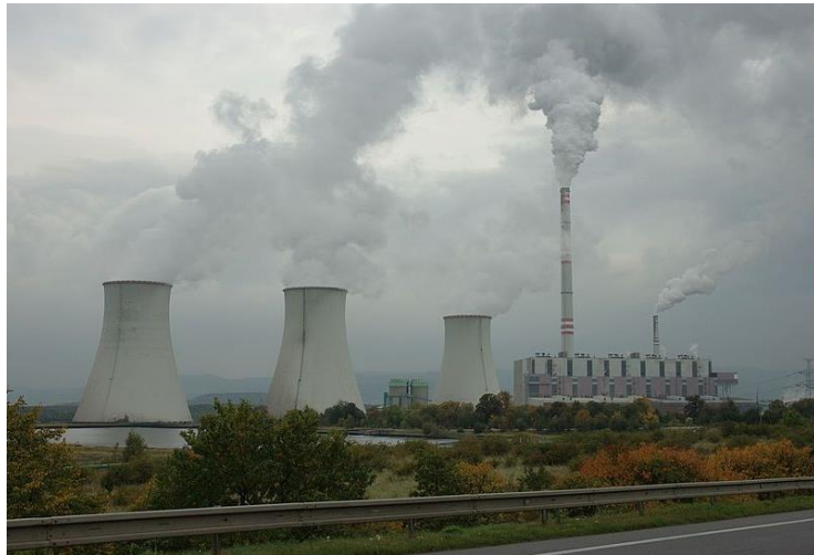
Elektrárna Prunéřov (severní Čechy)
