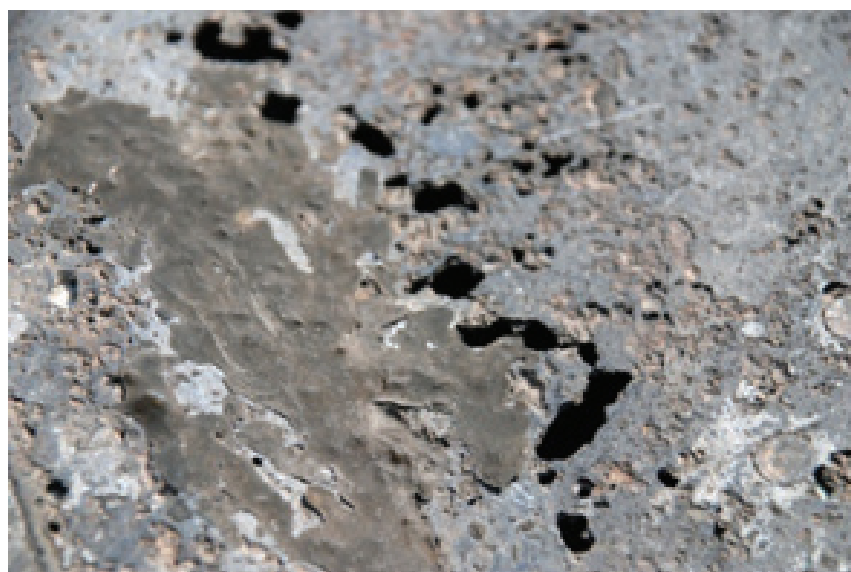
2. Atmosférická koroze hliníku na letadle Mig-17
