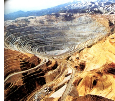
Jámový důl na měď Bingham v Utahu (4 km průměr, 800 m hloubka).
