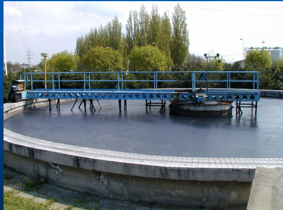
Obr. 123 Nepřetržitě pracující usazovák (zahusťovač) s lžebly:
