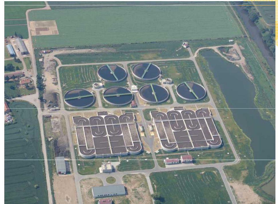
ČOV Brno – Modřice, Brněnské vodárny a kanalizace, a.s.
