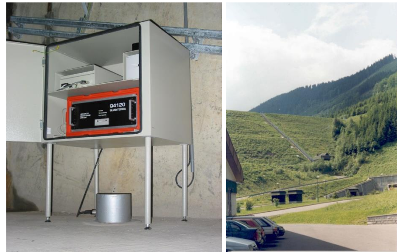
Stanice DLSC umístěná v hrázi nádrže Dlouhé Stráně.
