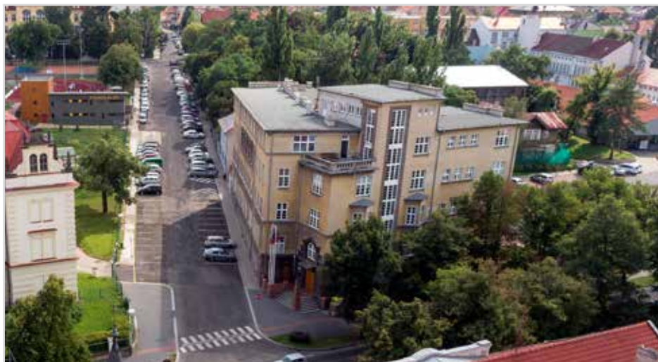
Obr. 1 Budova Velitelství 4. brn v Žatci (foto L. Čtvrtníček)
