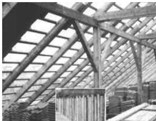
Obr. 2.20: Typické použití dřeva při zhotovování stavebních konstrukcí
